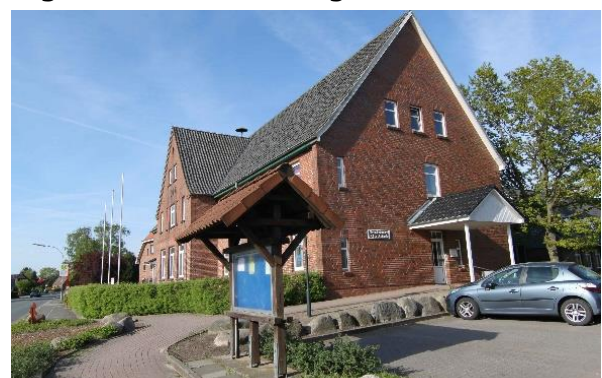
Südseite Alte Schule
