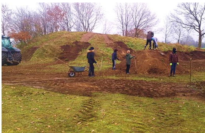
Bau der Dirtbike- Anlage im Dezember
